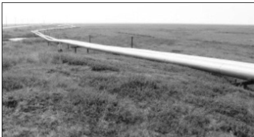
Рис. 3. Прокладка трубопровода по бугру пучения, район УКПГ-2, Ямбургское месторождение
