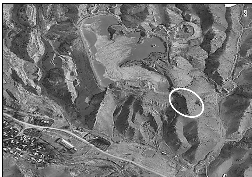
Рис. 1. Хвостохранилище №3 в Сумсаре Овалом показана зона сдвига массива горных работ
