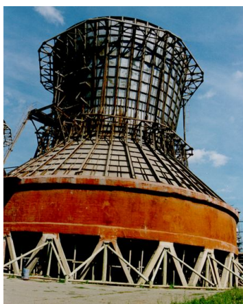
Рис. 6. Усиленная крупногабаритная градирня СК-1200, ОАО НКХХ
