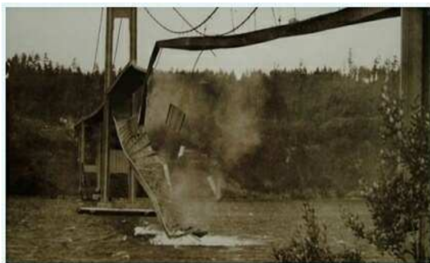
Рис.2. Обрушение Такомоского моста [1].
