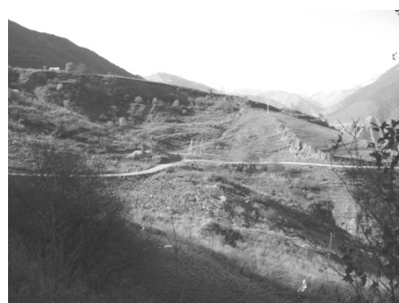
Рис.3. Деформация дороги оползневыми смещениями у с. Бугарой
