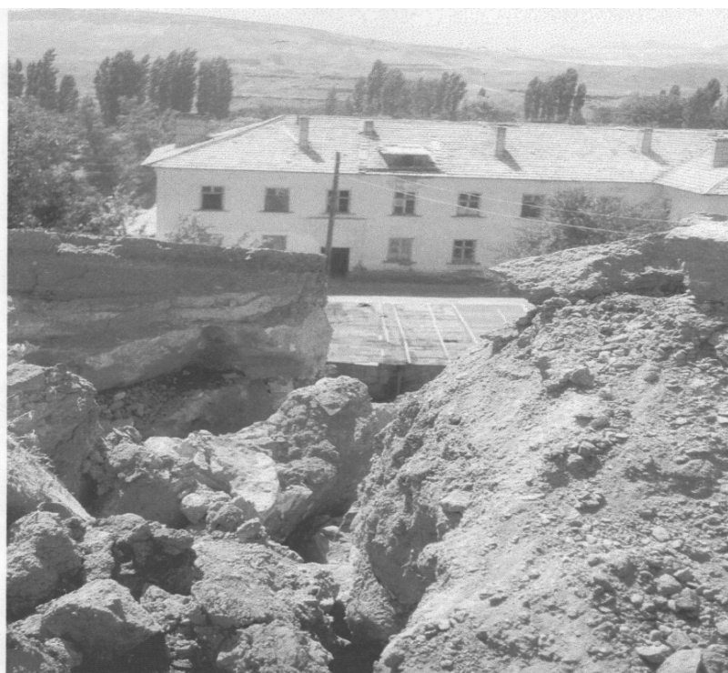
Рис. 3. Оползень в пос. Шекафтар спустя 40 лет после отработки рудника
