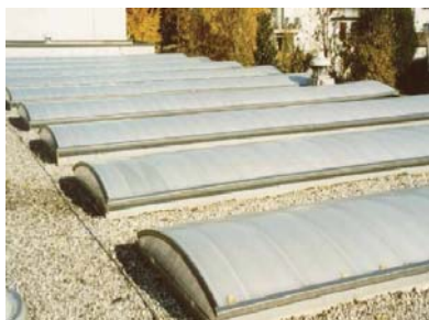
Рис.7. Зенитный ленточный фонарь
