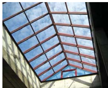
Рис.8. Зенитный панельный фонарь
