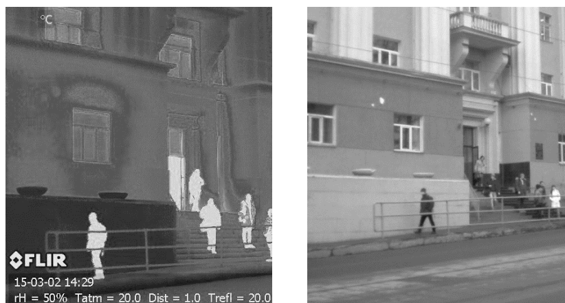
Рис.1. Тепловизионная съёмка центрального фасада здания
