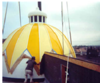
Рис. 9. Купол из армированного пластика
