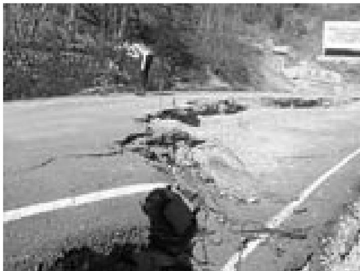
Рис. 17. Разрушение шоссе в результате схода оползня в селе Гендуши Амбролаурского района (Западная Грузия) [20]
