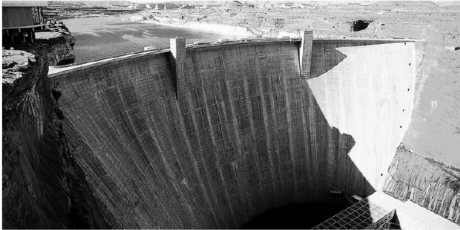
Рис. 21. Использование базовых станций для мониторинга искусственных объектов
