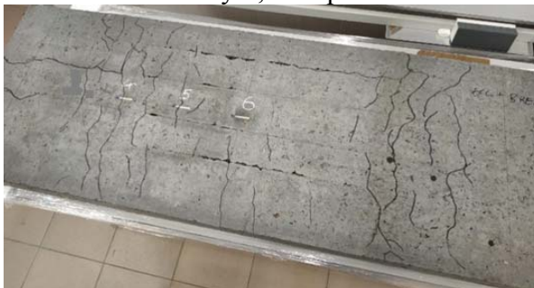
Рисунок 19 - Результаты трещин плита типа 2
