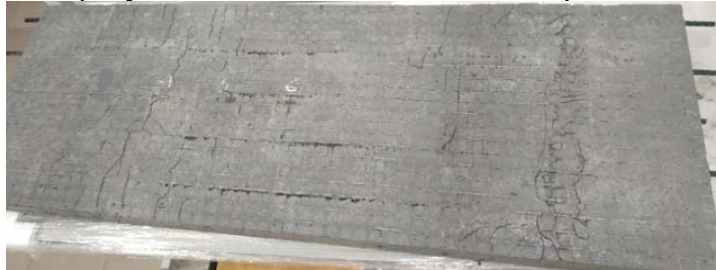
Рисунок 21 - Образование трещин плита типа 3
