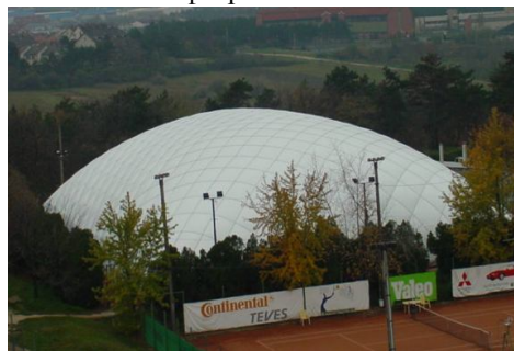
Рис. 15. Воздухоопорное пневматическое сооружение компании «GRABO-PLAN» из двухслойного воздухопроницаемого материала с утеплителем и сетью металлических оцинкованных тросов
