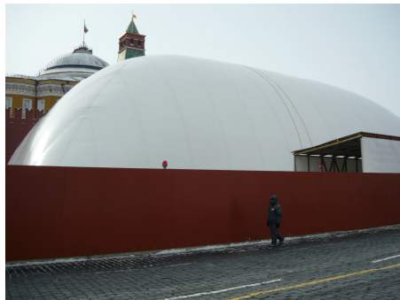
Рис. 14. Воздухоопорное пневматическое сооружение над Мавзолеем В.И. Ленина на Красной площади, Москва, февраль 2013
