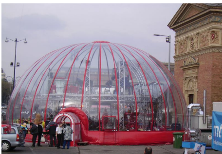
Рис. 16. Воздухоопорное пневматическое сооружение компании «GRABOPLAN» из прозрачного невоспламеняющегося материала, устойчивого к ультрафиолетовому излучению, с противогрибковым и грязеотталкивающим покрытием
