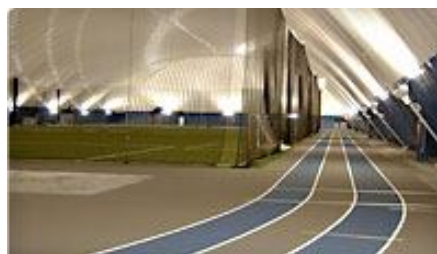
Рис. 21. Купол спортивного воздухоопорного сооружения 183\text{ м} \times 66,8\text{ м} \times 18\text{ м} , Ecole Louis Riel Ottawa, Ontario
