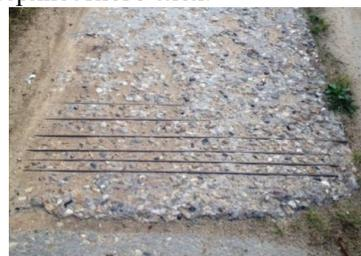
Рис. 4. Разрушение поверхностного слоя плит ПАГ
