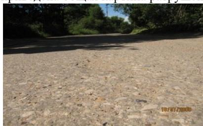
Рис. 3. Разрушение поверхностного слоя сборных ж/б плит
