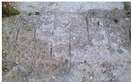
Рис. 2. Образование усадочных трещин в зоне арматуры
