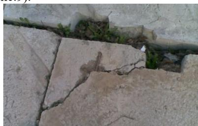
Рис. 8. Характер разрушения от совместного действия момента и поперечных сил.
