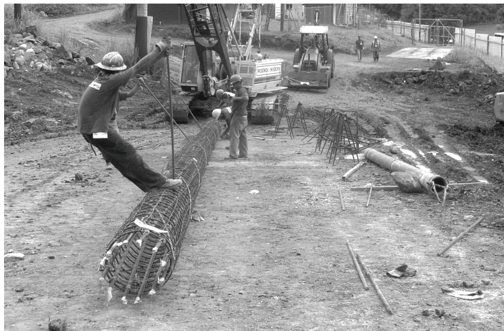
Рис. 1. Устранение деформации арматурного каркаса буронабивной сваи
