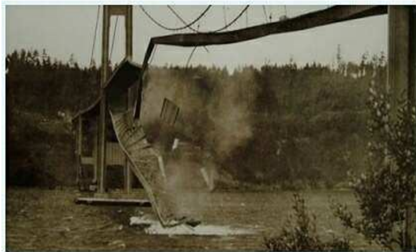
Рис.2. Обрушение Такомоского моста [1].
