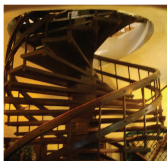
а) двусторонняя деревянная лестница в ресторане «Детинец» в г. Великий Новгород, Россия
