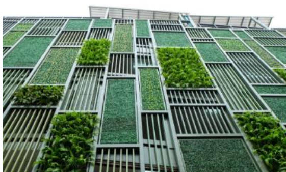
Рисунок 5 - Модульная система зелёного фасада [7]
