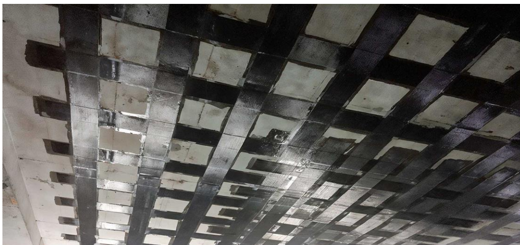
Рисунок 1 – Усиление перекрытия углеродной лентой
