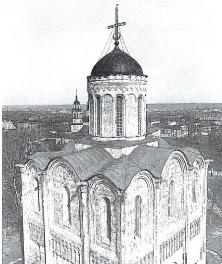
Рисунок 9 – Общий вид после реставрации. 1954
