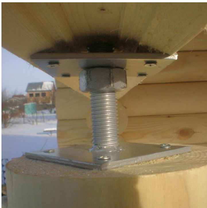
Рисунок 3 – Анкер регулировочный, компенсатор усадки
