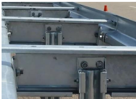
Рисунок 11 - Конические болты
