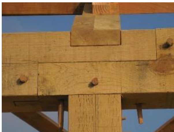
Рисунок 2 – применение отходов древесины в армирование деревянных конструкций
