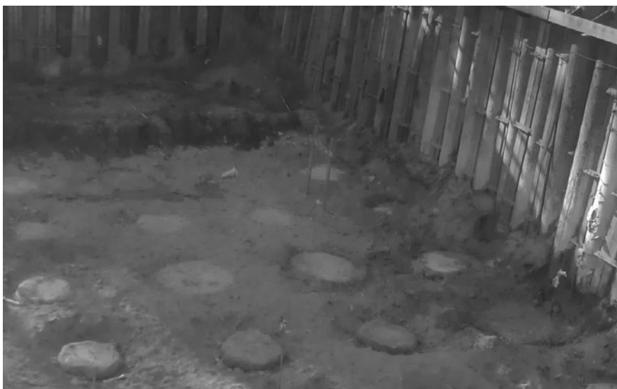
Рис. 4. Грунтоцементные сваи, созданные по технологии однокомпонентной струйной цементации
