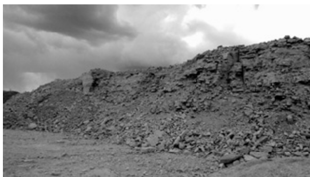
Рис. 2. Разрушающийся борт карьера, с местами высачивания подземных вод
