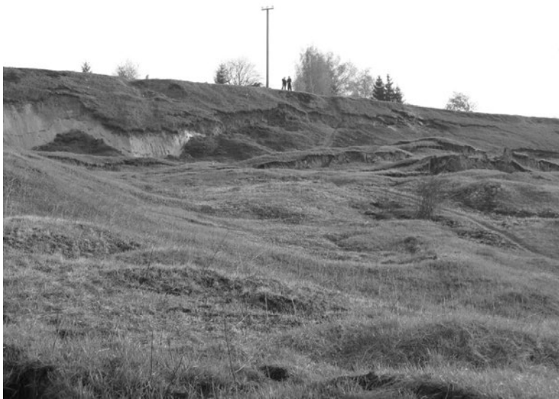
Рис. 1. Оползень на лессовом склоне крутизной 5^{\circ} - 8^{\circ} (периферия г. Купянск, Харьковская обл.)
