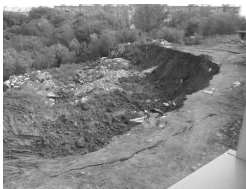
Рис. 4. Разрыхленный оползневой массив (17 сентября 2015 г.)
