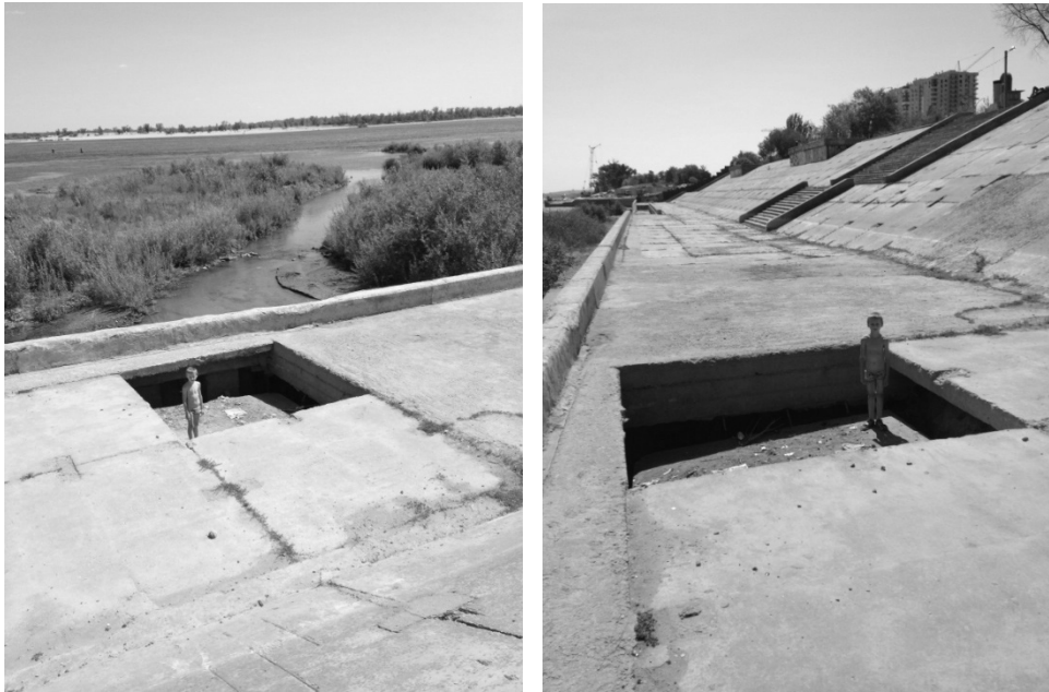
Рис. 1, 2. Провал плиты, примыкающей к нижнему ростверку разграничивающему укрепленный склон и пойму р. Волги
