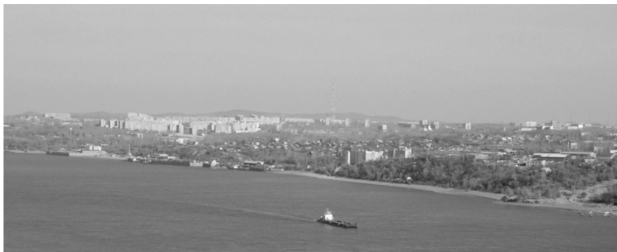
Рис. 1. Оползневой склон на правом берегу р. Амур ( K_{оп} 0,7-0,95 )
