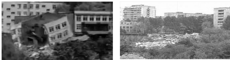
Рис. 1. Оползень на ж/м «Тополь» (1997 г.)
