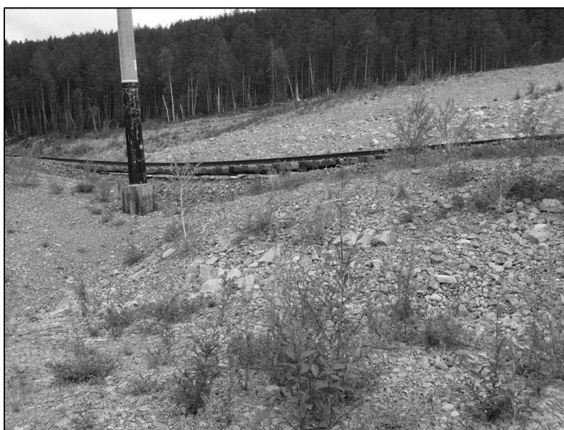
Рис. 1. Провисание неэксплуатируемого железнодорожного полотна в результате многолетней осадки насыпи
