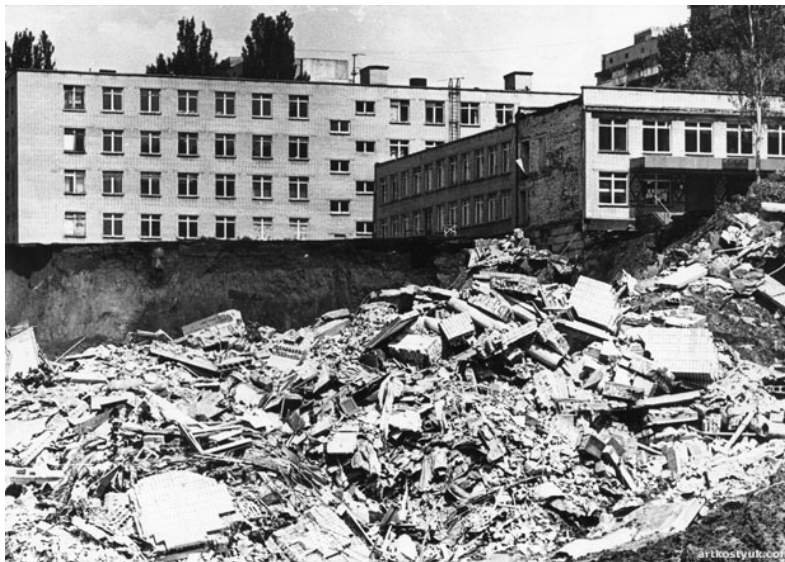
Рис. 2. Оползень на лессовом склоне крутизной 5^{\circ} - 10^{\circ} в жилом массиве г. Днепропетровск
