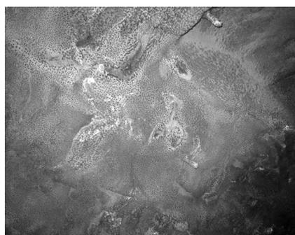
**Рис. 1. Следы микробиологической коррозии на набрызг-бетоне, квершлаг № 1, гор. -425 м Яковлевского рудника**
