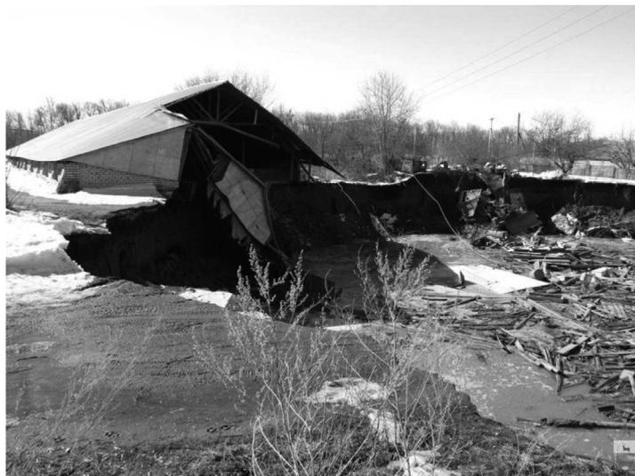
**Рис. 1. Карстовый провал в п. Бутурлино (2013 г.)**
