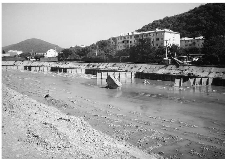
**Рис. 2. Участки разрушенных наводнением берегоукреплений
