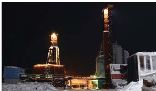
Фото 1. АБК рудника «Маяк»
