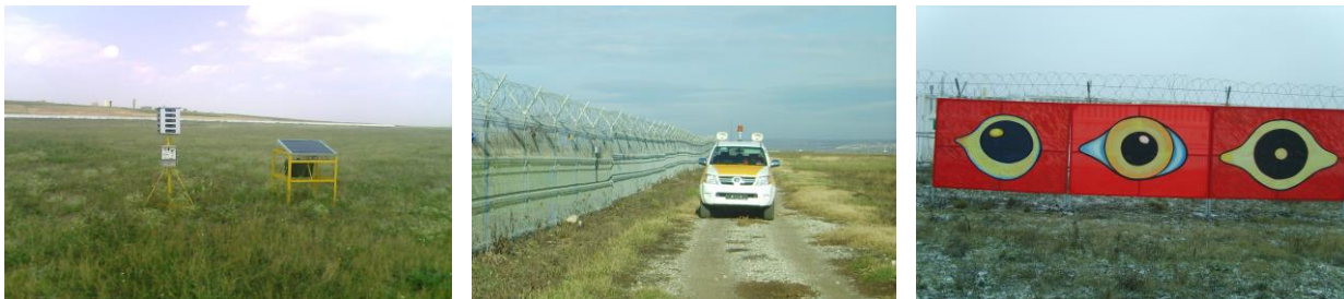
Рис. 6. Биоакустическая установка “Bird Gard” и мобильная биоакустическая установка ”Беркут”, установка подрамников с изображением глаз хищной птицы
