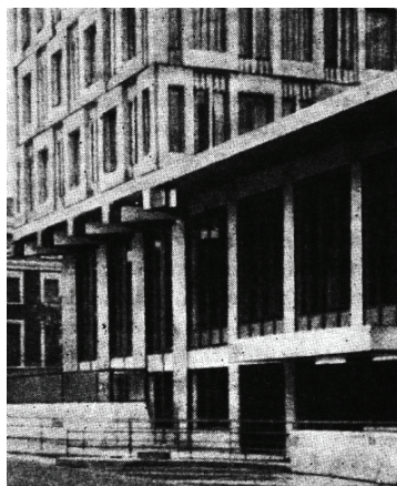
Рис. 8. Железобетонные конструкции здания посольства США в Лондоне
