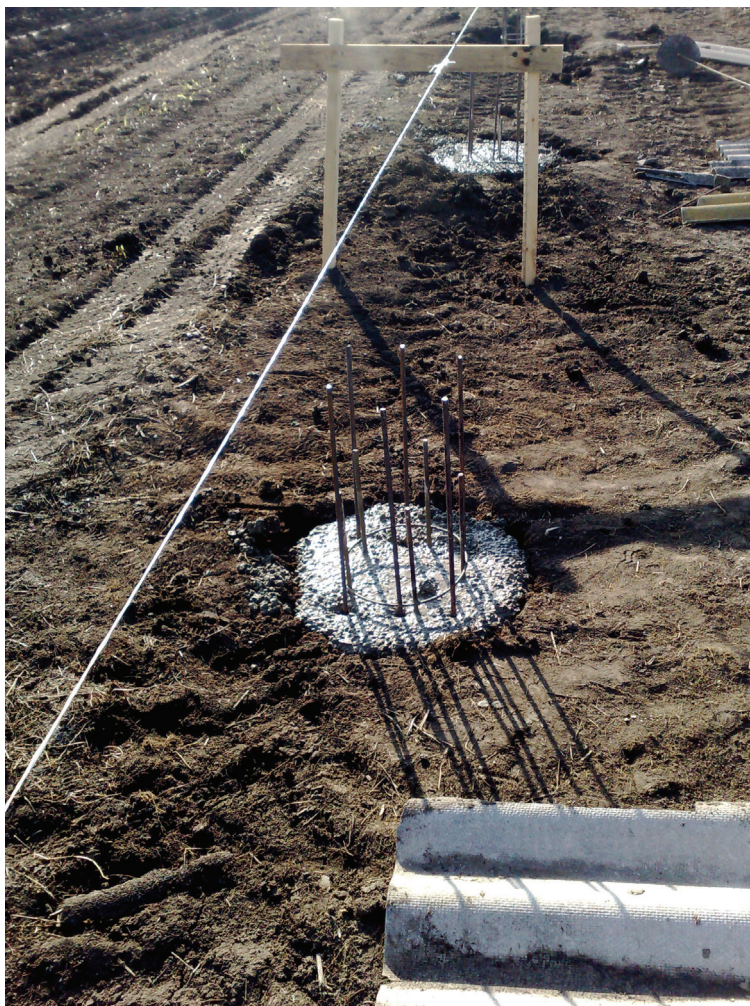
Рис. 1. Внешний вид фундаментов под колонны одноэтажного здания
