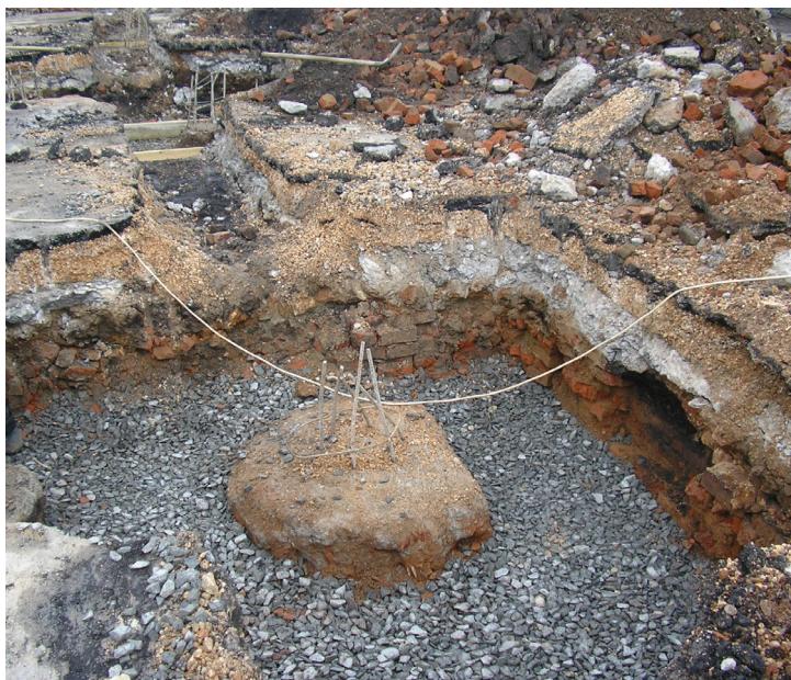
Рис. 2. Внешний вид фундамента в насыпном грунте с «культурным» слоем асфальтобетонного покрытия
