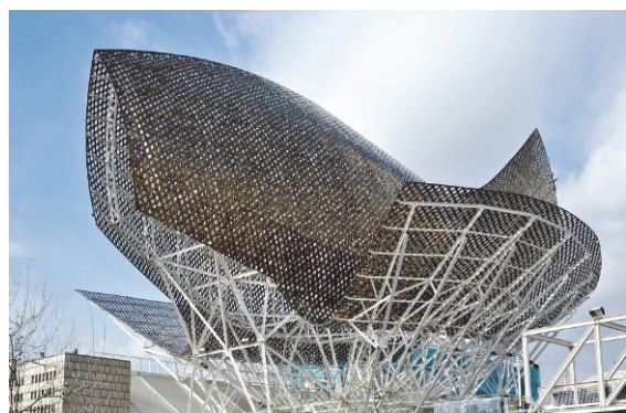
Рис. 10. Скульптура над олимпийским павильоном, 1992, Барселона, Испания, арх. Ф. Гери ( дигитальная архитектура ) (URL: https://losko.ru/wp-content/uploads/2017/07/FullSizeRender-5-5.jpg (дата обращения: 30.01.2022))
