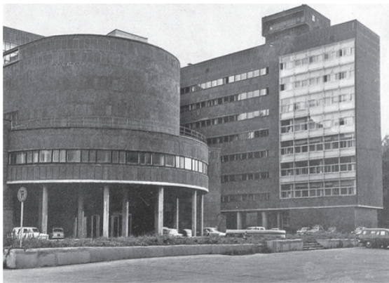
Рис. 2. Здание Центросоюза, 1928–1936, Москва, Россия, арх. Ле Корбюзье ( функционализм ) (URL: http://corbusier.totalarch.com/files/lc20/084_02.jpg (дата обращения: 30.01.2021))
